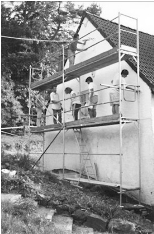
UGD renoviert Schwabenhaus - Fassade
