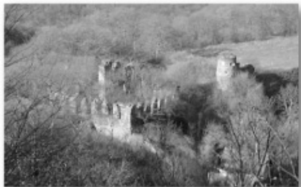
Die „Bastion“ heute. Vorsicht: Einsturzgefahr!
