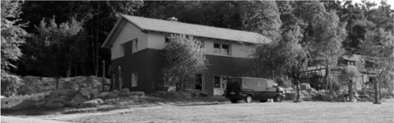
gung. Wir haben festgestellt, dass der Primärenergiebedarf von handelsüblicher Mineralwolle annähernd 75 mal, und der von Zellulose 16 mal höher ist als der von Stroh. Hochgerechnet auf unser Haus ergibt sich eine Einsparung an Primärenergie gegenüber einem mit Mineralwolle und Zellulose gedämmten gleichgroßen Gebäude in Höhe von ca. 129.000 kwh/m<sup>2</sup>.
