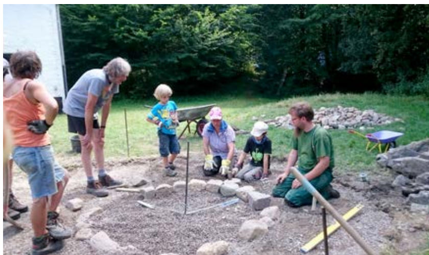
Kinderbaustelle am Schwabenhaus
