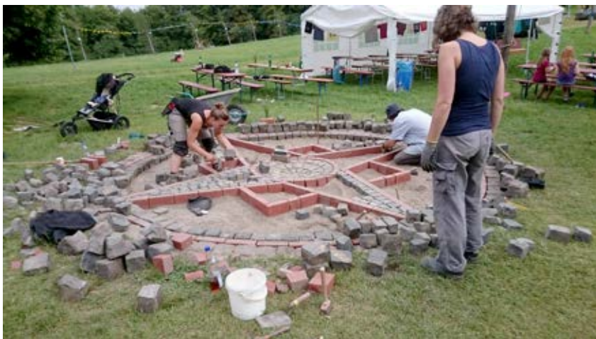
Der BaseG-Stern für die neue Feuerstelle ist gelegt
